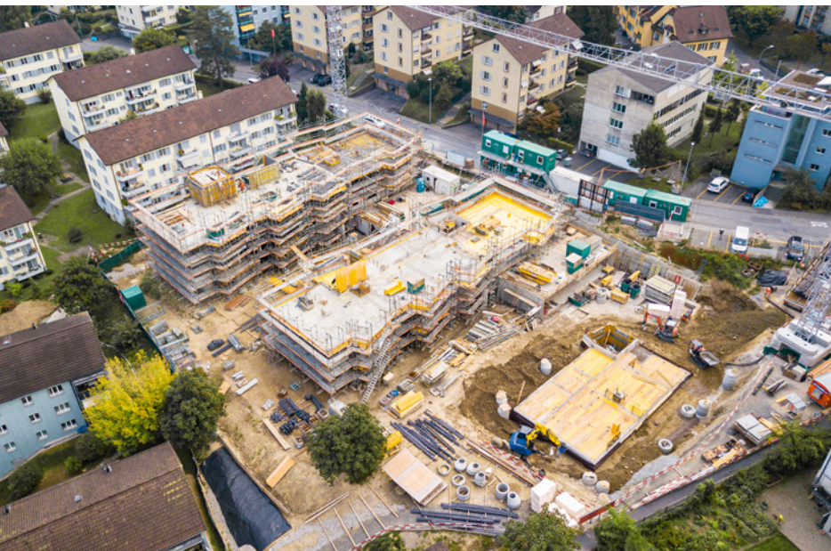
Die Baustelle Weinbergli wird immer grösser.
