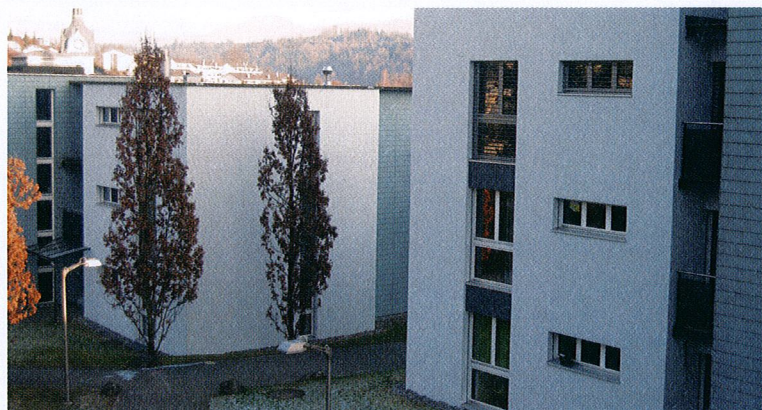
Neuer Verputz für SBL-Häuser in Adligenswil.
