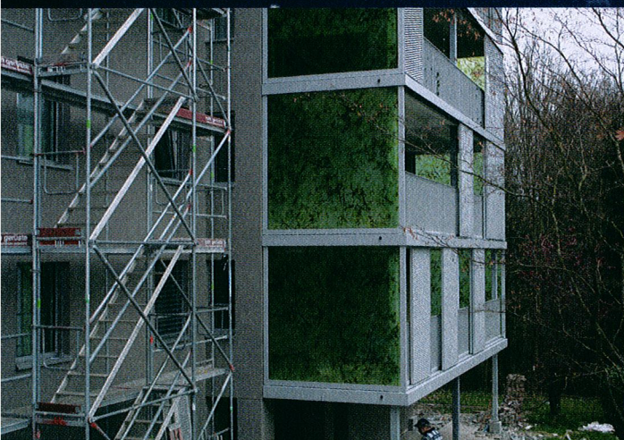
Mehr Wohnkomfort, weniger Energieverlust dank neuer Hülle im Obergütschrain 6.
