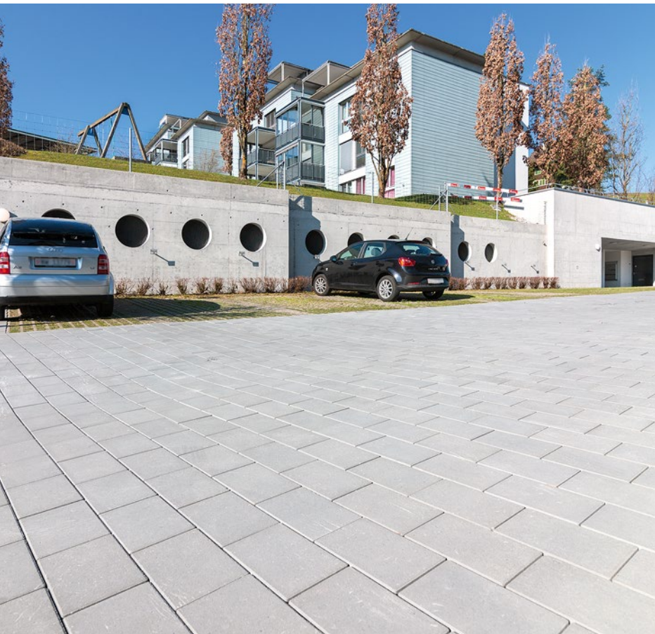
Wie verwandelt: der Dorfweg Adligenswil mit neuer Pflasterung.
